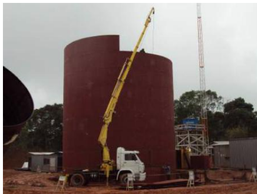
Figura 13 - Montagem do Costado com Guincho Mecânico
