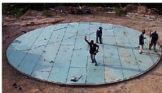
Figura 11 - Montagem do Fundo - Posicionamento da Chaparia
