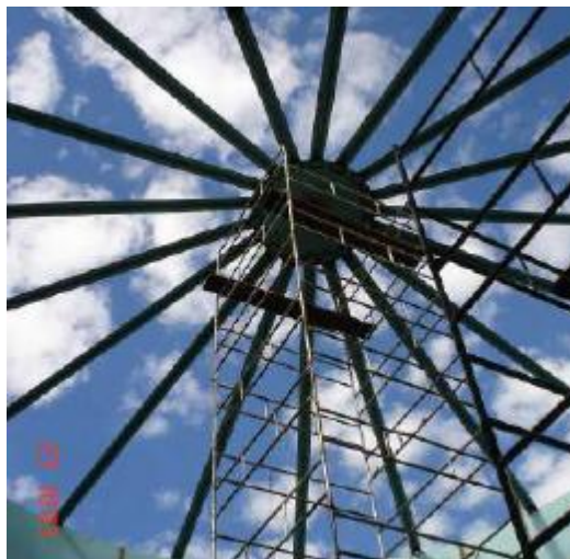
Figura 16 - Estrutura do Teto Cônico Autosuportado. Inclinação 12°
