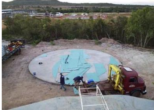
Figura 10 - Distribuição das Chapas do Fundo c/ Guincho Mecânico
