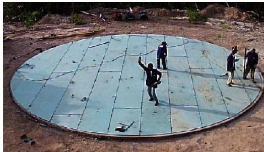
Figura 11 - Montagem do Fundo - Posicionamento da Chaparia
