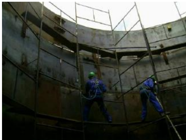
Figura 20 - Andaimos Internos Tubulares Simples - Tipo Satélite
