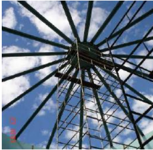
Figura 16 - Estrutura do Teto Cônico Autosuportado. Inclinação 12°
