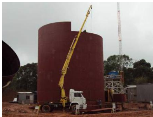
Figura 13 - Montagem do Costado com Guincho Mecânico
