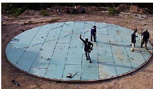
Figura 11 - Montagem do Fundo - Posicionamento da Chaparia
