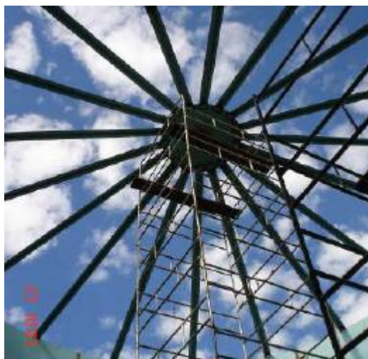
Figura 16 - Estrutura do Teto Cônico Autosuportado. Inclinação 12°
