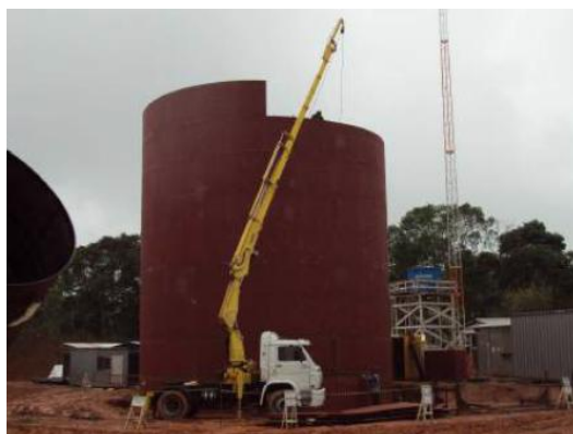
Figura 13 - Montagem do Costado com Guincho Mecânico
