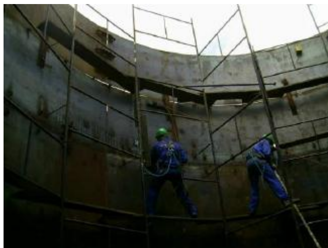
Figura 20 - Andaimos Internos Tubulares Simples - Tipo Satélite
