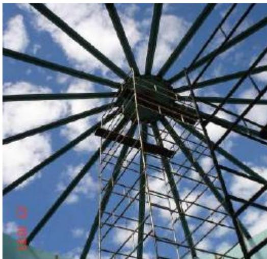
Figura 16 - Estrutura do Teto Cônico Autosuportado. Inclinação 12°
