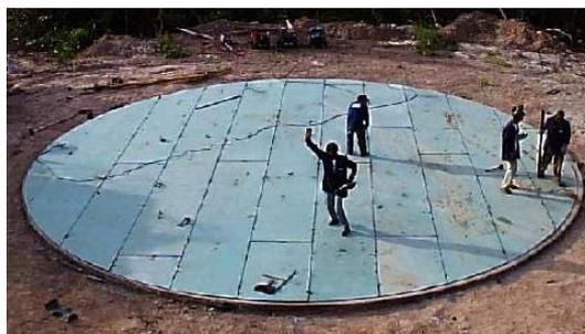
Figura 11 - Montagem do Fundo - Posicionamento da Chaparia
