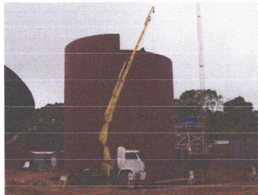
Figura 13 - Montagem do Costado com Guincho Mecânico
