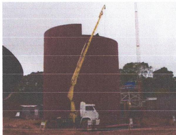
Figura 13 - Montagem do Costado com Guincho Mecânico
