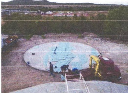
Figura 10 - Distribuição das Chapas do Fundo c/ Guincho Mecânico
