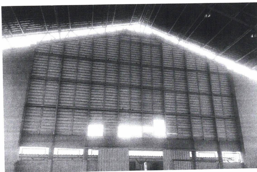
Figura 4 - Exemplo: Vista do Brise contido na Quadra Poliesportiva da EMEF Prof.ª Vera Lucia Vitali, que terão os perfis metálicos longitunidades parcialmente fechados.
