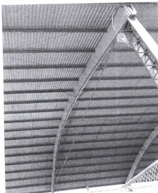
Figura 3 - Exemplo: Vista do Fechamento de Elemento Estrutural, Tesoura Metálica
