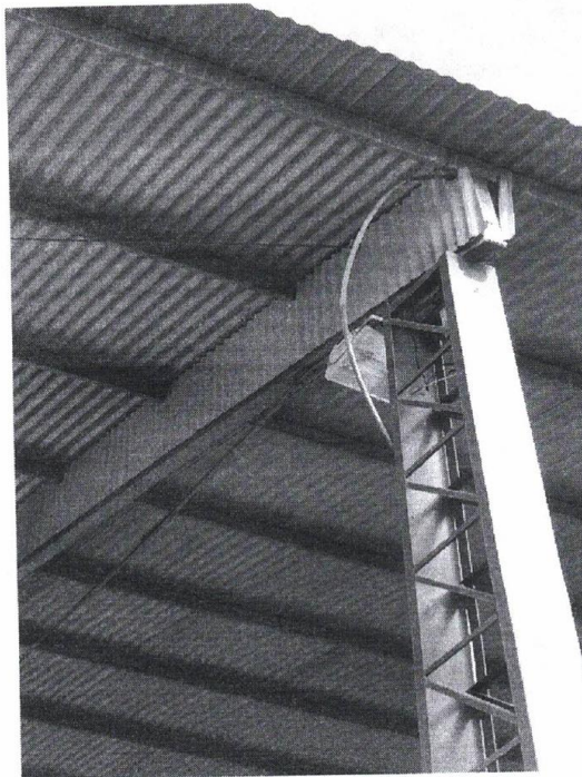
Figura 1 - Exemplo: Vista do Fechamento de Elemento Estrutural, Tesoura Metálica
