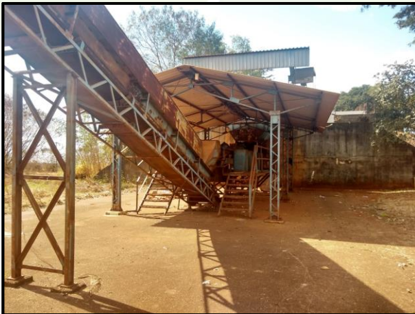
Usina de Reciclagem desativada
