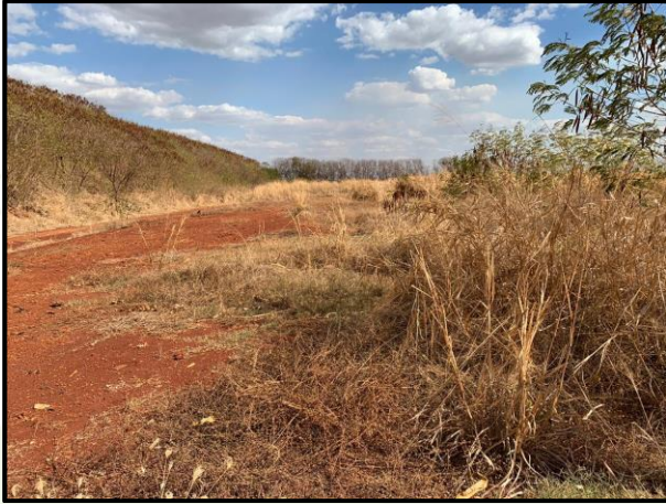
Vistas do Aterro Sanitário Municipal
