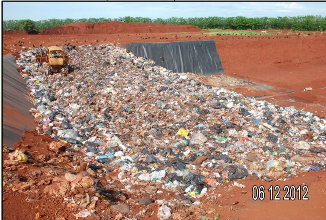
Figura 30 – Operação da Vala 02
