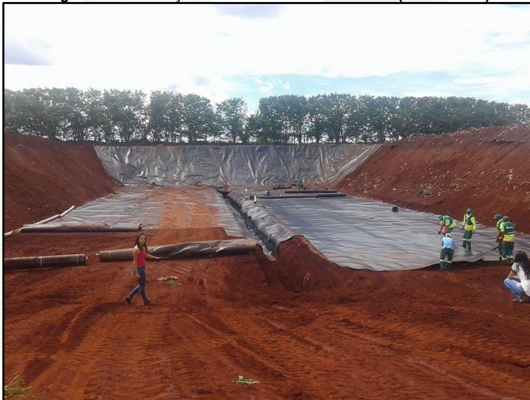
Figura 31 – Instalação de infraestrutura na Vala 04 (ano de 2016)
