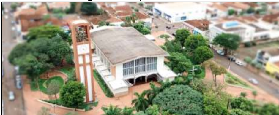
Figura 58 – Praça São Sebastião
