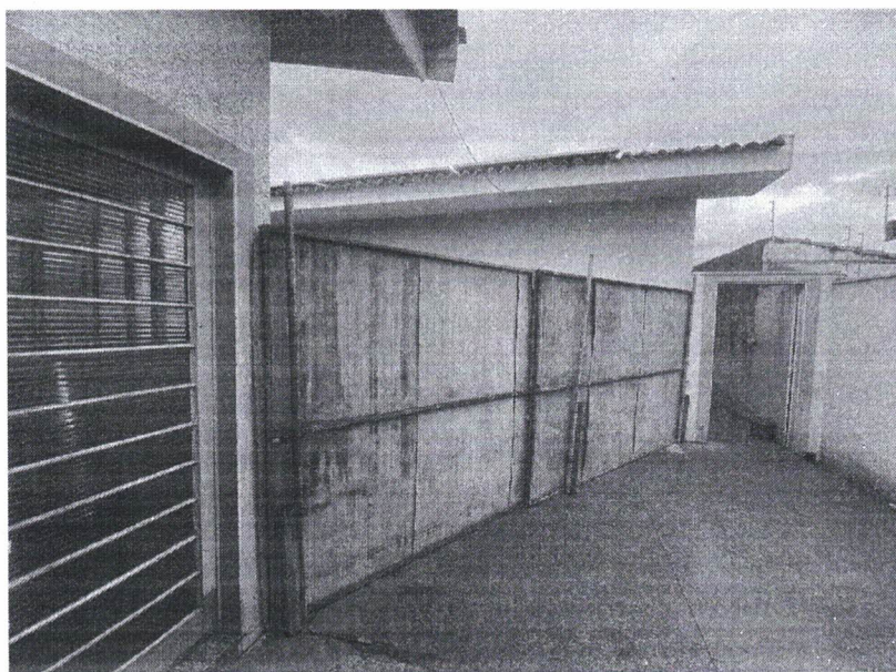
Figura 1 - Isolamento de Área
