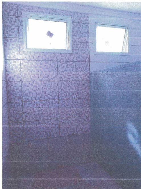
30 – Vista do sanitário feminino com o espaço dos lavatórios.
